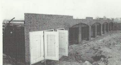
Mei/juni 1992 - De garages onder de driving range in aanbouw
