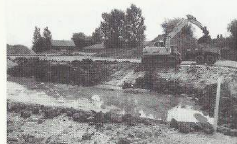
De aanleg is in volle gang.
