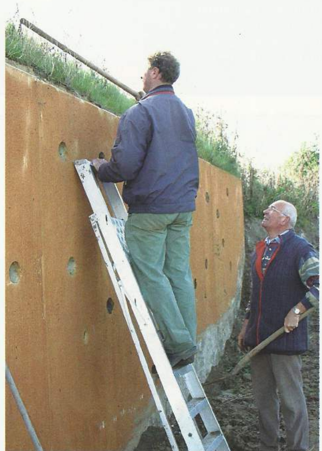
Het schoonmaken van de holen en daarna vullen met lemig zand.
