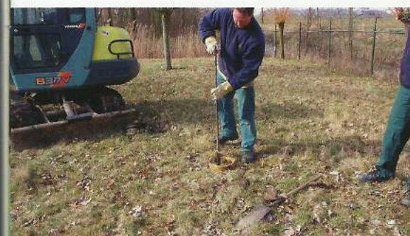
Het boren van het gat voor de paal, circa 120 cm diep, verstevigd met PVC buis
